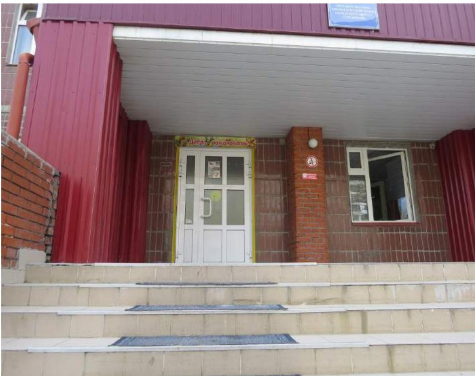
Фото 7 – Входная дверь с площадкой №1. Отсутствуют фиксаторы положений «открыто» и «закрыто», имеется контрастная маркировка
