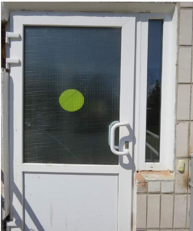
Фото 15 – Входная дверь с площадкой № 2 и кнопкой вызова сотрудника. Отсутствуют фиксаторы положений «открыто» и «закрыто».
